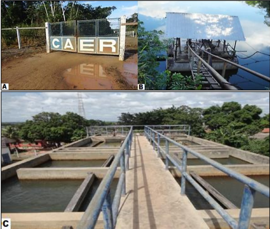
Figura 2 - Sistema de captação e tratamento de água
